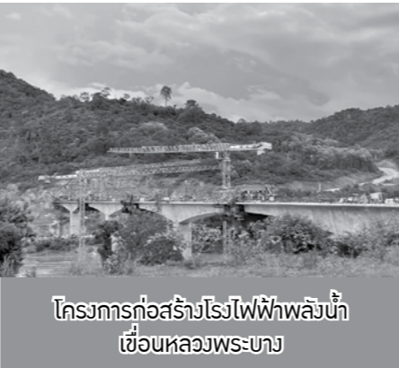
โครงการก่อสร้างโรงไฟฟ้าพลังน้ำเขื่อนหลวงพระบาง
